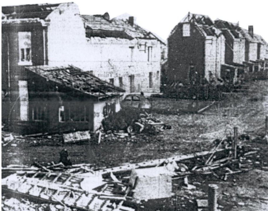
Dégâts de la tornade à La Rochelle en 1971 (crédit photo Sud Ouest)
